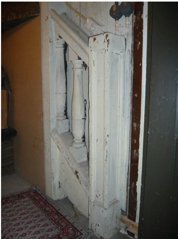
Detail van de oorspronkelijke trap naar het orgel.
